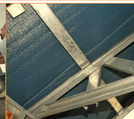
Espuma Multicolor en estructura metálica
